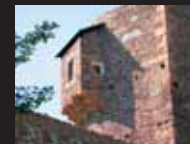
Esempio di bertesca su torre a sviluppo circolare
