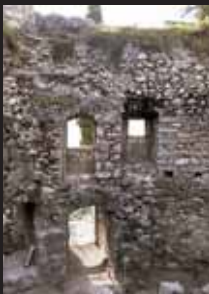
Stato conservativo prima dei lavori
