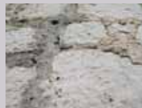
A fianco, dall'alto: Paramento esterno lato nord. Perdita totale delle malte di allettamento e di giunto Paramento esterno. Compresenza di malte originarie e cementizie (interventi anni'50)
