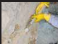
Consolidamento con iniezione degli intonaci interni decorati a finto bugnato a terzo livello
