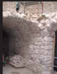
Ricostruzione dell'angolata e delle volte al primo livello
