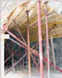
Centinatura per la ricostruzione parziale delle volte
