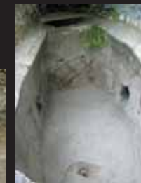
La cisterna per la riserva idrica con doppia vasca filtrante intonacata a cocciopesto
