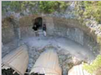
Centinatura dei tre avvolti del primo livello preparatori alla ricostruzione muraria
