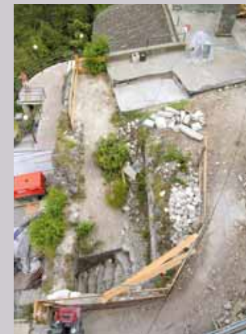
Stato delle aree pertinenziali prima degli scavi
