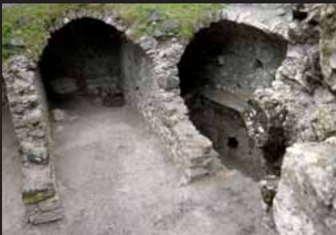
Stato delle volte prima dei lavori
