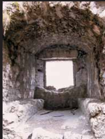
Dettaglio finestra di osservazione
