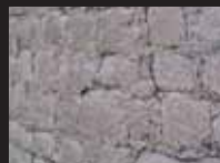
Paramento originario cinquecentesco con giunti rifilanti
