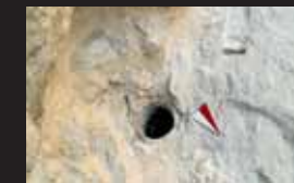
Tubazione originaria in cotto per la raccolta delle acque meteoriche in collegamento alla cisterna
