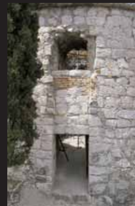
Porta con doppia chiusura e difesa piombante di accesso al primo livello
