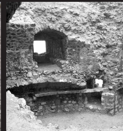
La canaletta di raccolta dell'acqua della copertura nella cisterna ripositionata sulle mensole nel restauro del '59
