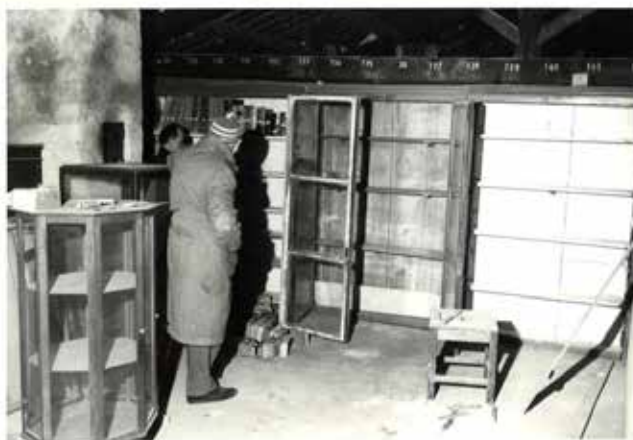
SOLAI DI LEVANTE DURANTE I LAVORI
