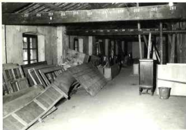
SOLAI DI LEVANTE DURANTE I LAVORI
