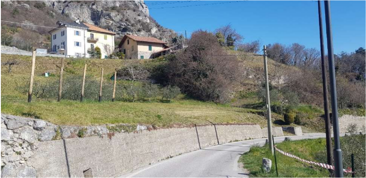
Figura 12: scendendo lungo la strada l'individuazione dei due percorsi risulta sempre ardua, e non risultano incisioni o canalizzazioni.
