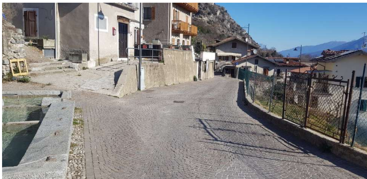
Figura 10: Si nota come la via di deflusso A non trovi una via preferenziale e con tutta probabilità si disperda tra sede stradale, orti, giardini e campi, probabilmente smaltendosi anche attraverso la rete di collettamento delle acque meteoriche pubblica.
