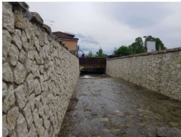
FIGURA 11. Ottobre 2021. Ponte di via Grez visto da monte. Dopo i lavori effettuati da SBM PAT la luce sotto il ponte è pressoché raddoppiata, i muri arginali sono stati rettificati e ricostruiti, il fondo è stato stabilizzato.
