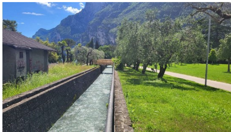
FOTO 11. Torrente Varone. Nuova passerella in legno a monte della confluenza
