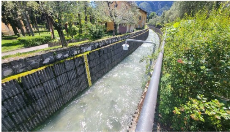
FOTO 9. Torrente Varone. Stazione idrometrica e di rilevamento della portata
