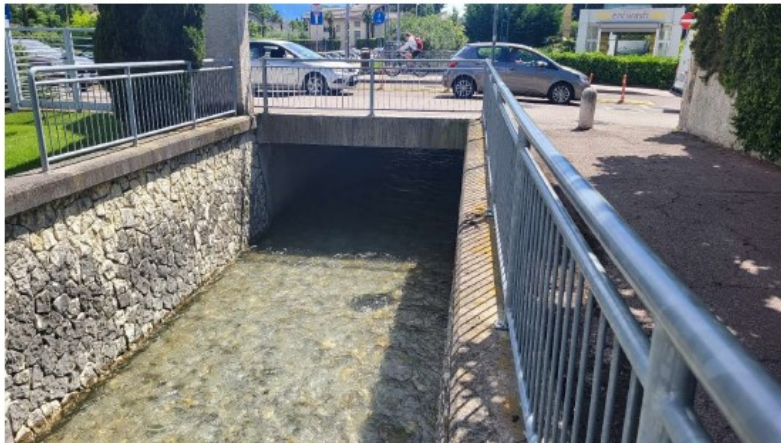
FOTO 28. Torrente Albola. Tratto a monte di viale Rovereto : vista verso valle
