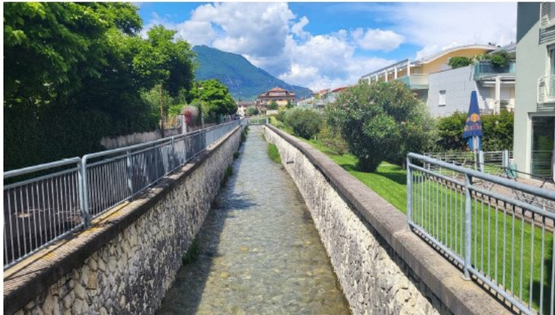
FOTO 27. Torrente Albola. Tratto a monte di viale Rovereto : vista verso monte
