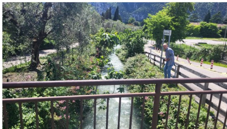
FOTO 4. Torrente Varone. ponte di viale Rovereto : vista verso valle
