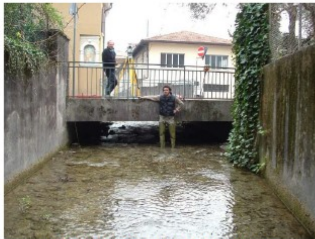
FIGURA 10. Aprile 2005. Ponte di via Grez.
