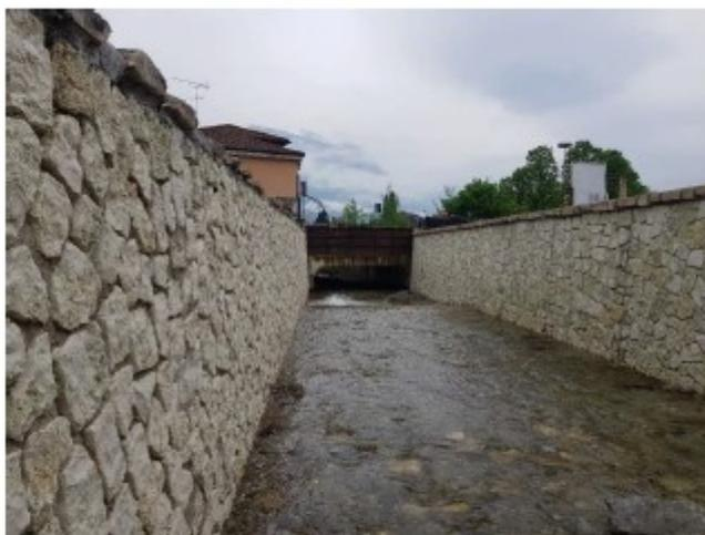
*FIGURA 11. Ottobre 2021. Ponte di via Grez visto da monte. Dopo i lavori effettuati da SBM PAT la luce sotto il ponte è pressochè raddoppiata, i muri arginali sono stati rettificati e ricostruiti, il fondo è stato stabilizzato.*
