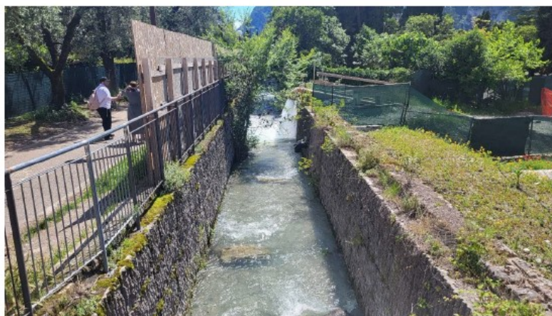
FOTO 24. Torrente Albola. Tratto a valle di viale Rovereto, vista verso valle. Si noti lo scarico proveniente dal cantiere Palacongressi.
