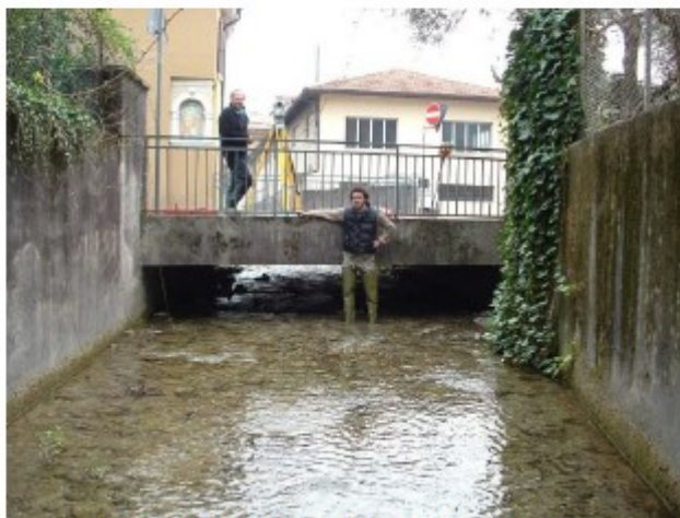
FIGURA 10. Aprile 2005. Ponte di via Grez.
