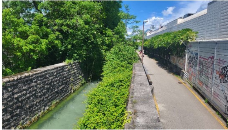
FOTO 1. Torrente Varone. Tratto a monte di viale Rovereto : vista verso monte
