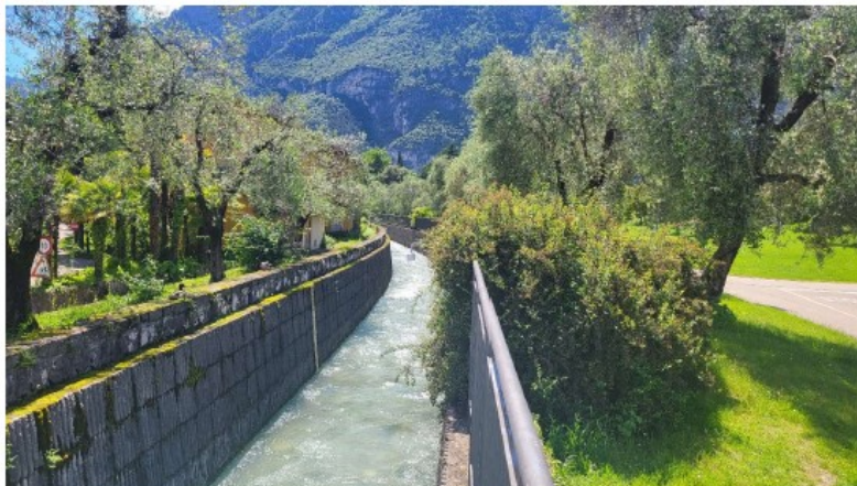
FOTO 8. Torrente Varone. Tratto sotto viale Rovereto : vista verso valle
