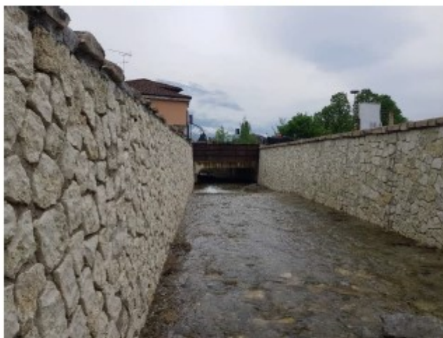
FIGURA 11. Ottobre 2021. Ponte di via Grez visto da monte. Dopo i lavori effettuati da SBM PAT la luce sotto il ponte è pressochè raddoppiata, i muri arginali sono stati rettificati e ricostruiti, il fondo è stato stabilizzato.
