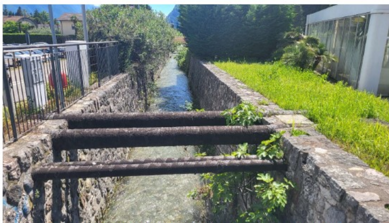
FOTO 26. Torrente Albola. ponte di viale Rovereto : vista verso valle
