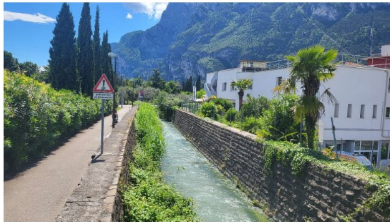
1. FOTO 2. Torrente Varone. Tratto a monte di viale Rovereto : vista verso valle
