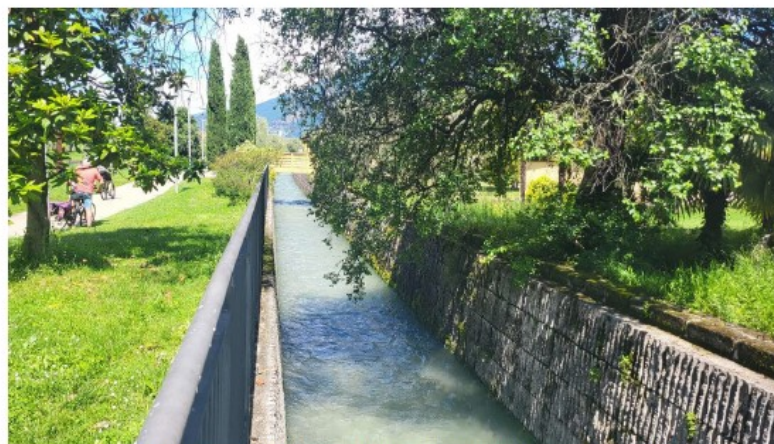
FOTO 12. Torrente Varone. Nuova passerella in legno, vista da valle
