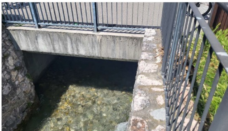
FOTO 25. Torrente Albola. ponte di viale Rovereto : vista verso monte
