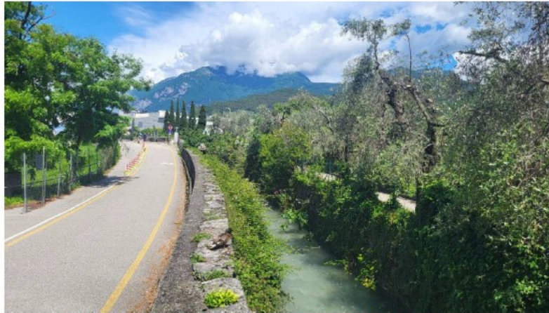
FOTO 5. Torrente Varone. Tratto sotto viale Rovereto : vista verso monte
