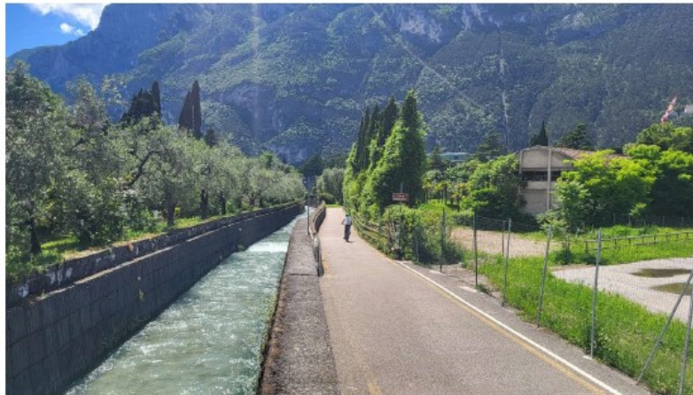
FOTO 6. Torrente Varone. Tratto sotto viale Rovereto : vista verso valle
