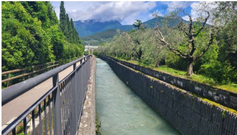
FOTO 7. Torrente Varone. Tratto sotto viale Rovereto : vista verso monte
