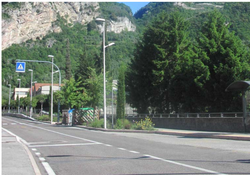
Via Nuova: impianto di recente realizzazione costituito da apparecchi stradali totalmente schermati, installati su palo in acciaio verniciato, con linea di alimentazione interrata. Gli apparecchi funzionali all'illuminazione della strada sono equipaggiati con lampade ai vapori di sodio ad alta pressione mentre quelli funzionali all'illuminazione del marciapiede sono dotati di sorgenti a LED.
