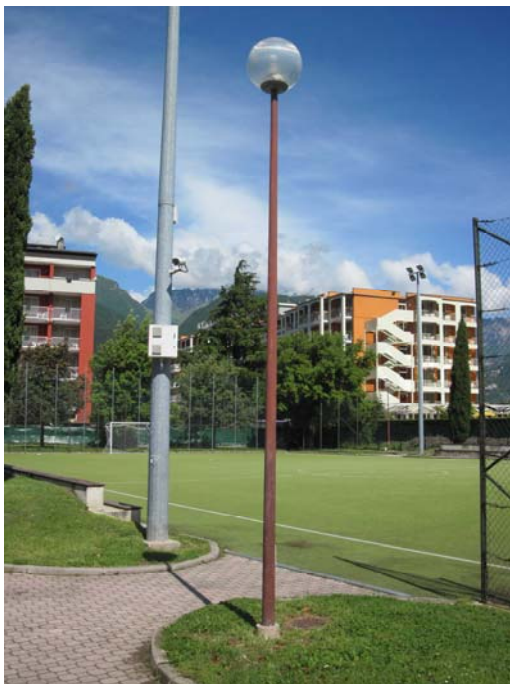
Apparecchio di arredo urbano di tipo diffondente installato nel Parco pubblico di Via Brione, classificabile come apparecchio di classe E ai sensi dell'Allegato C al Piano provinciale.
