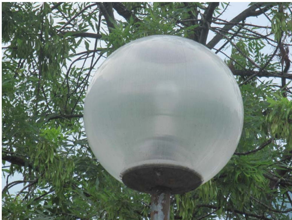
Apparecchi di arredo urbano di tipo diffondente installati nel parcheggio di Via Canella, classificabili come apparecchi di classe E ai sensi dell'Allegato C al Piano provinciale.
