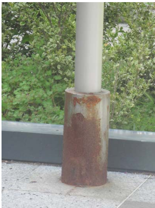
Piazzale Della Mimosa: sostegno con base arrugginita.
