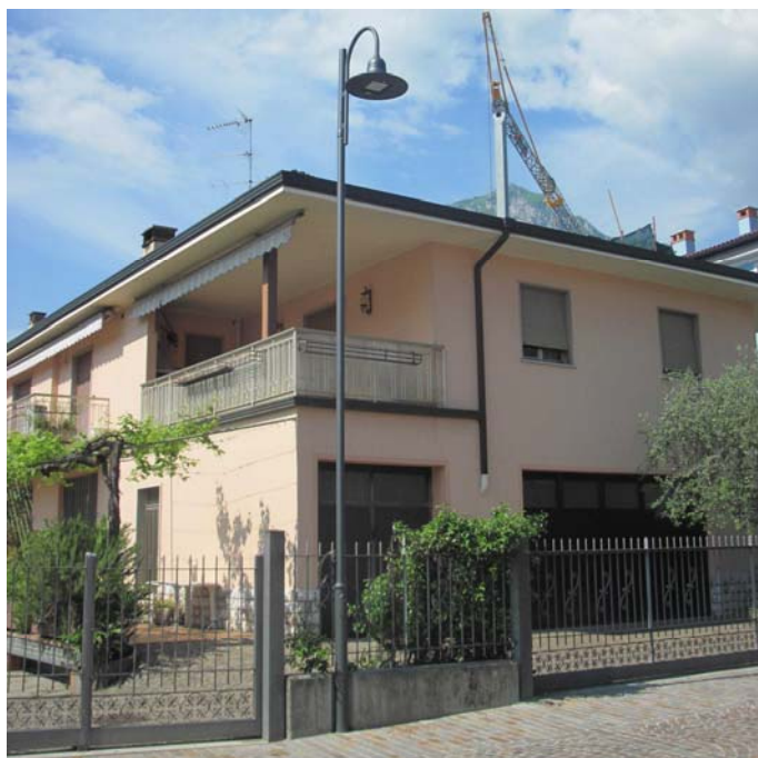
Via Nuova: impianto di recente realizzazione costituito da apparecchi stradali totalmente schermati, installati su palo in acciaio verniciato, con linea di alimentazione interrata. Gli apparecchi funzionali all'illuminazione della strada sono equipaggiati con lampade ai vapori di sodio ad alta pressione mentre quelli funzionali all'illuminazione del marciapiede sono dotati di sorgenti a LED.
