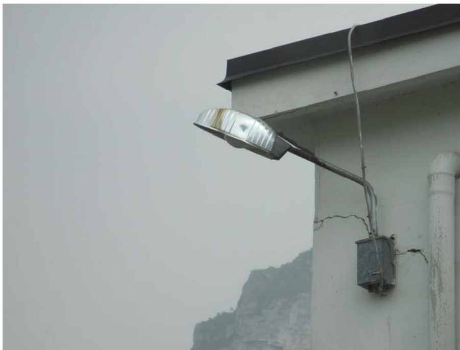
Via Grez: armatura stradale obsoleta priva di vetro di chiusura
