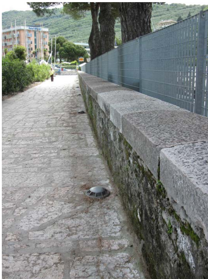
Apparecchi segnapasso installati lungo il viale d'accesso ai Giardini di San Nicolò, classificabili come apparecchi di classe D ai sensi dell'Allegato C al Piano provinciale.
