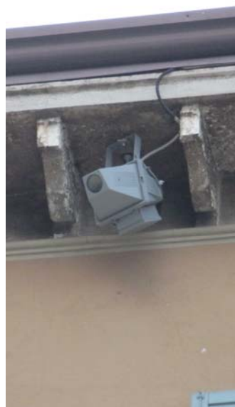
Proiettore installato in posizione sottogronda per l'illuminazione artistica di Palazzo Pretorio
