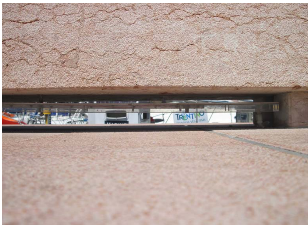
Strisce LED installate sotto le panchine di Spiaggia Olivi, classificabili come apparecchi di classe D ai sensi dell'Allegato C al Piano provinciale.
