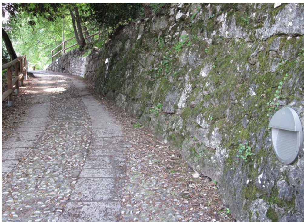
Apparecchi totalmente schermati installati ad incasso a parete lungo il Sentiero per il Bastione, classificabili come apparecchi di classe A ai sensi dell'Allegato C al Piano provinciale.
