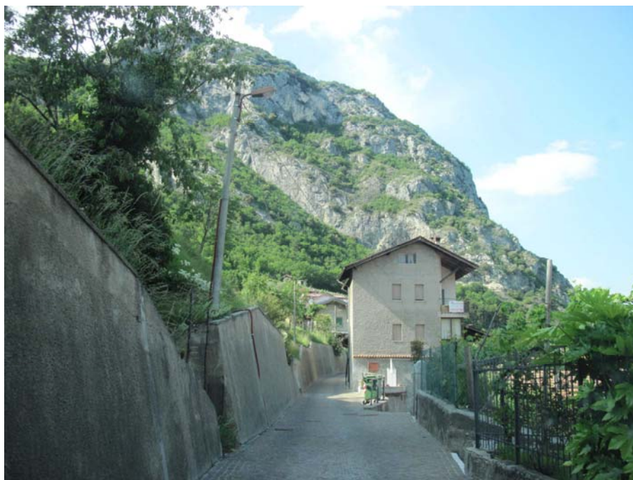
Località Pregasina: sostegno fuori piombo in c.a.c.
