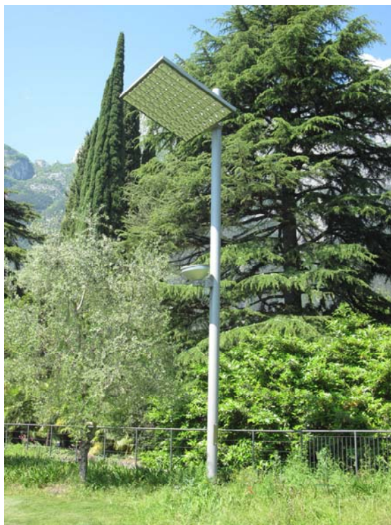
Apparecchio decorativo di tipo diffondente installato nel Parco Miralago, classificabile come apparecchio di classe C ai sensi dell'Allegato C al Piano provinciale.
