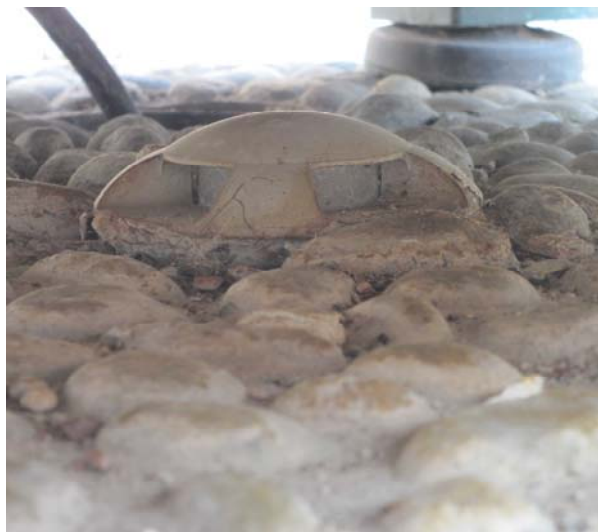
Apparecchi ad incasso installati sotto i vasi del Lungolago D'Annunzio, classificabili come apparecchi di classe D ai sensi dell'Allegato C al Piano provinciale.
