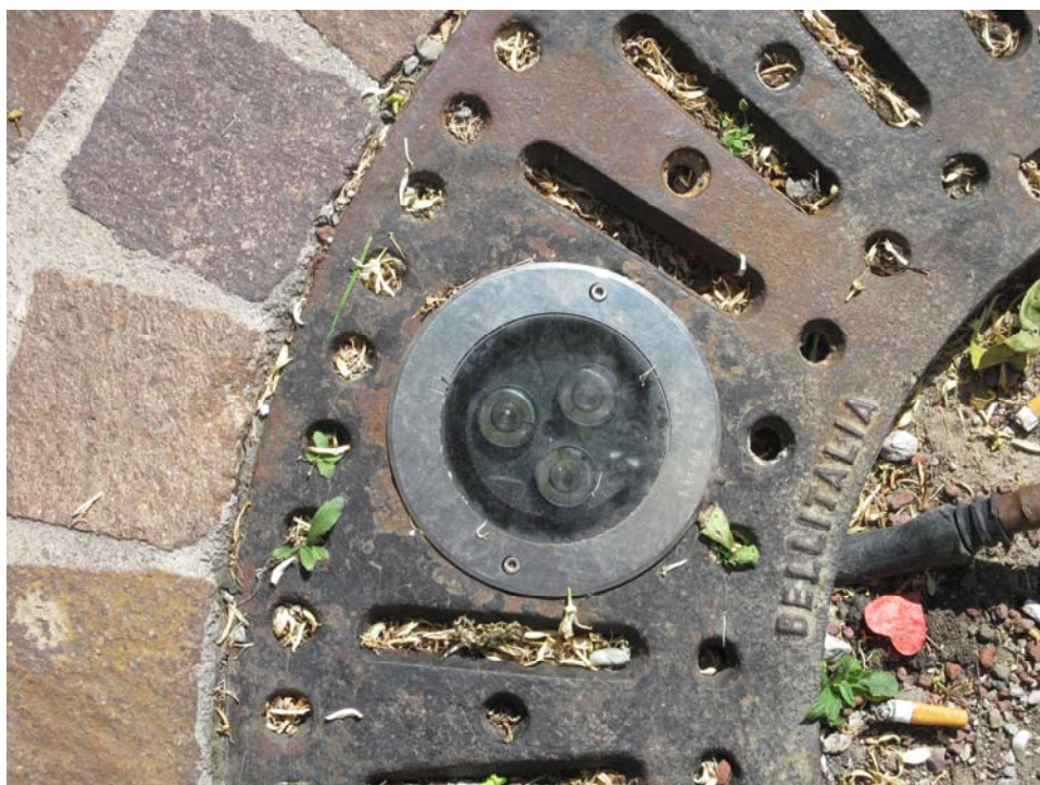
Apparecchi installati ad incasso in via Dante Alighieri per l'illuminazione delle piante ai lati della carreggiata, classificabili come apparecchi di classe D ai sensi dell'Allegato C al Piano provinciale.
