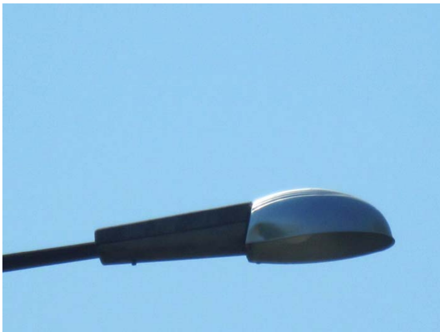
Località San Giacomo: armatura stradale obsoleta priva di vetro di chiusura
