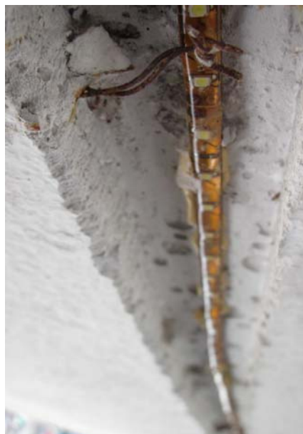
Strisce LED installate sotto le panchine all'incrocio di Via Dante Alighieri con Via Roma, classificabili come apparecchi di classe D ai sensi dell'Allegato C al Piano provinciale.
