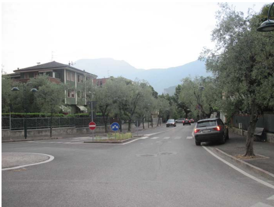
Viale Antonio Rosmini: impianto di recente realizzazione costituito da apparecchi di tipo decorativo totalmente schermati dotati di sorgenti ai vapori di sodio ad alta pressione ed installati su palo di tipo decorativo in acciaio verniciato, con linea di alimentazione interrata.
