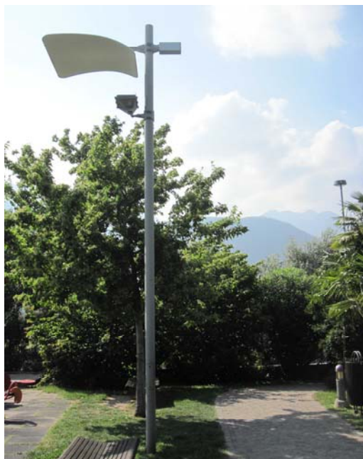
Apparecchio decorativo di tipo diffondente installato nel Centro Sportivo Comunale di Via Miorelli, classificabile come apparecchio di classe C ai sensi dell'Allegato C al Piano provinciale.
