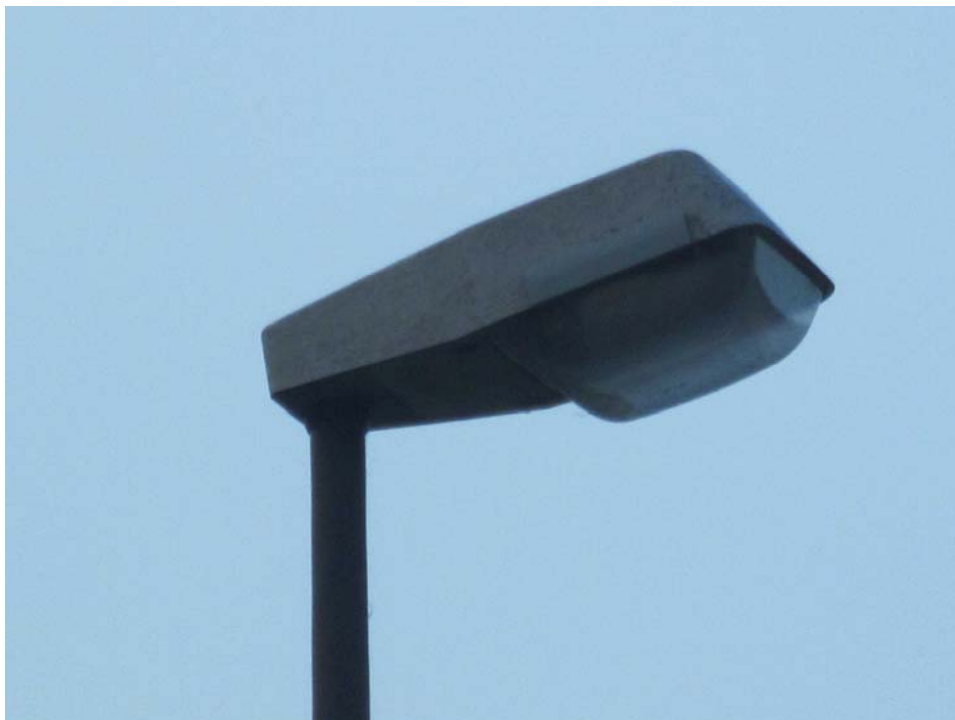
Via Fornasetta: armatura stradale dotata di vetro di chiusura a coppa prismatica classificabile come apparecchio di classe B ai sensi dell'Allegato C al Piano provinciale
