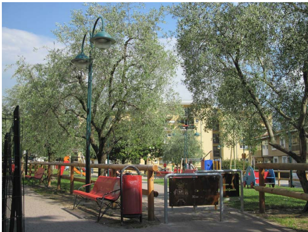
Apparecchi decorativi di tipo diffondente installati nel giardino pubblico di Via Isonzo, classificabili come apparecchi di classe B ai sensi dell'Allegato C al Piano provinciale.
