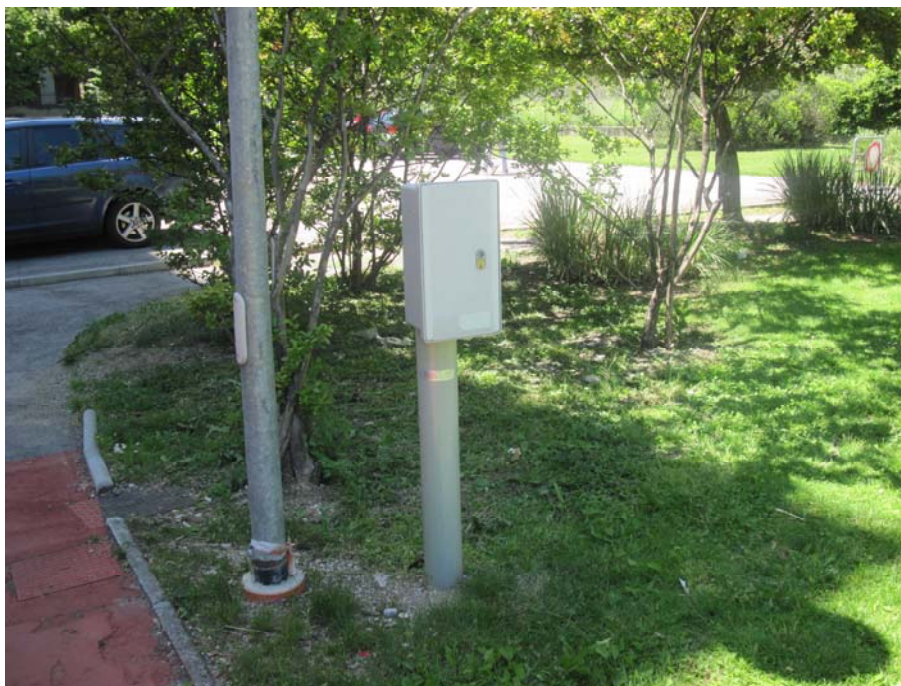
Via Archimede Martini: sostegno con collarino danneggiato.
