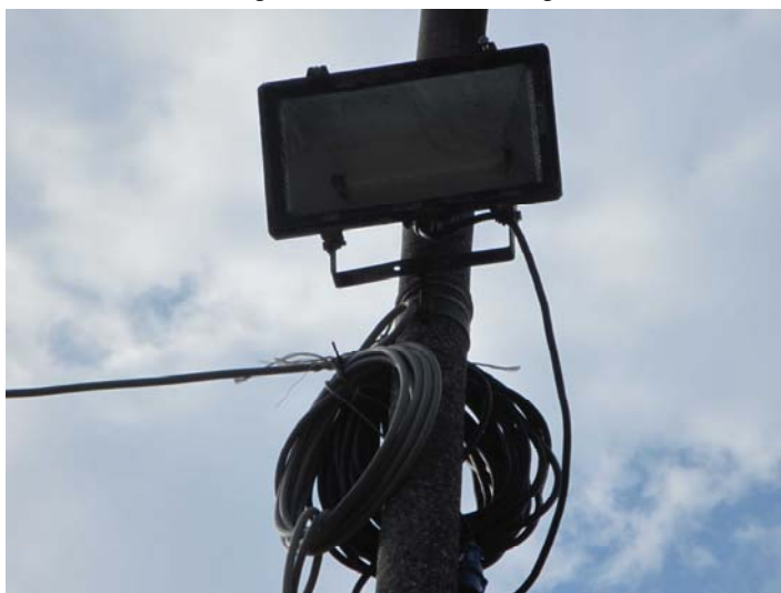
Via Zara: giunzioni di cavi su sostegno in c.a.c.
