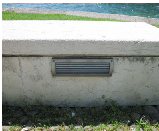
Incassi a parete installati nel Parco la Rocca (Museo Civico) per l'illuminazione dei viali pedonali, classificabili come apparecchi di classe A ai sensi dell'Allegato C al Piano provinciale.
