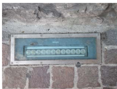
Apparecchi installati ad incasso a terra per l'illuminazione artistica di Porta San Michele
