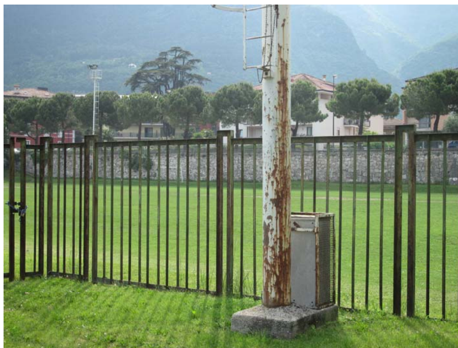
Viale Trento, Campo Sportivo Comunale Rione De Gasperi: sostegno in avanzato stato di degrado.
