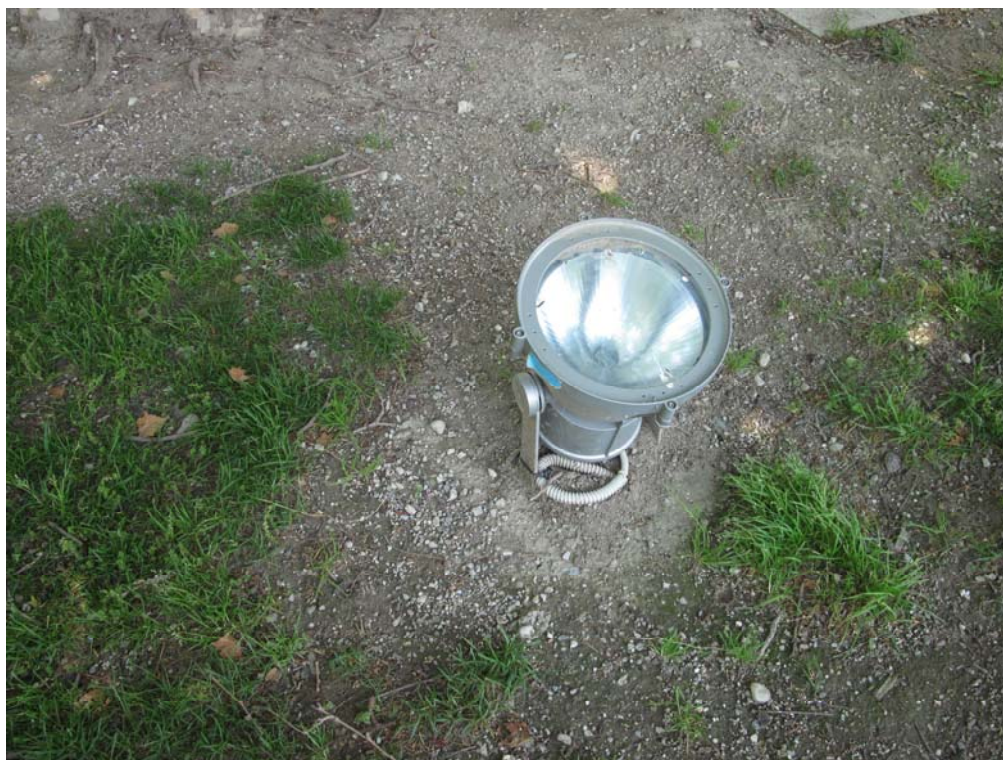
Proiettori installati nel Parco la Rocca (Museo Civico) per l'illuminazione di alberi, classificabili come apparecchi di classe D ai sensi dell'Allegato C al Piano provinciale.
