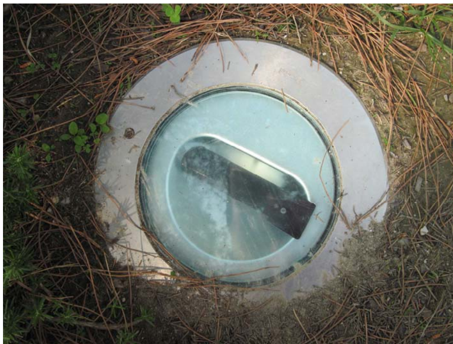
Apparecchi ad incasso installati nel Lungolago D'Annunzio per l'illuminazione di alcune piante, classificabili come apparecchi di classe D ai sensi dell'Allegato C al Piano provinciale.
