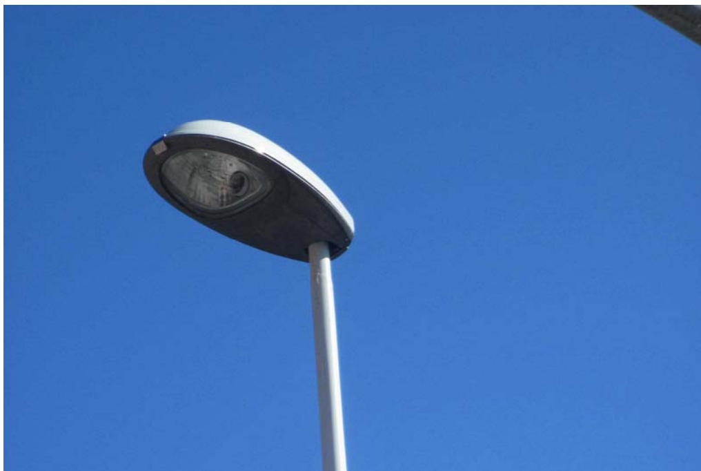
Via Nuova: armatura stradale dotata di vetro di chiusura piano classificabile come apparecchio di classe A ai sensi dell'Allegato C al Piano provinciale
