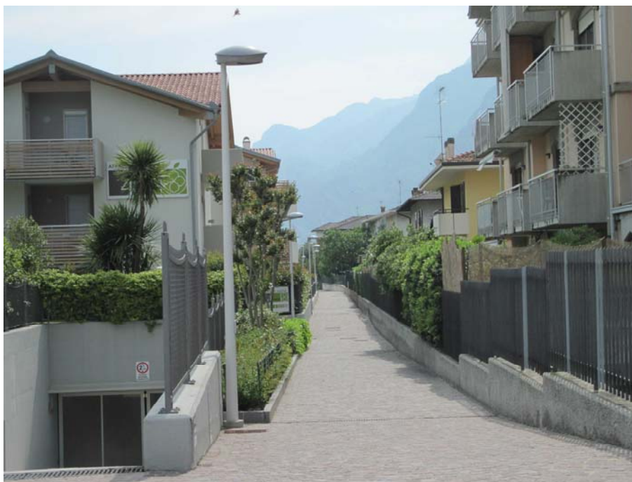
Via Filanda: impianto di recente realizzazione costituito da apparecchi stradali totalmente schermati equipaggiati con lampade ai vapori di sodio ad alta pressione ed installati su palo in vetroresina, con linea di alimentazione interrata.
