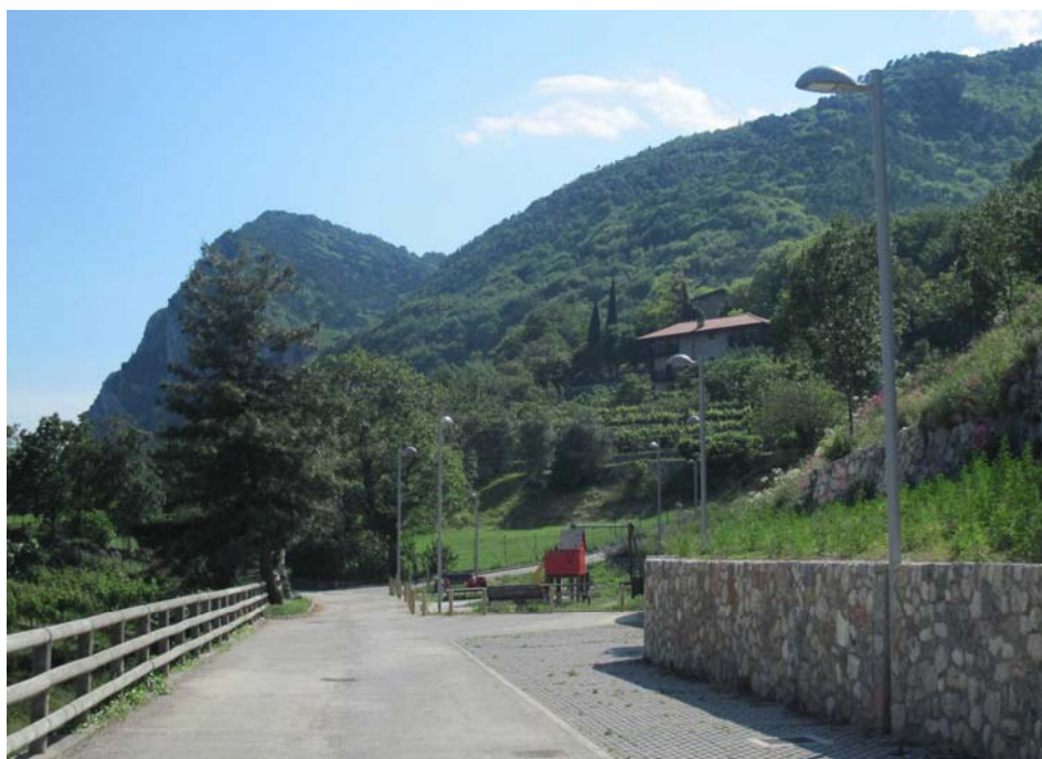
Località Pregasina: esempio di nuovo impianto costituito da apparecchi decorativi totalmente schermati dotati di sorgente a LED ed installati su palo in acciaio verniciato, con linea di alimentazione interrata.
