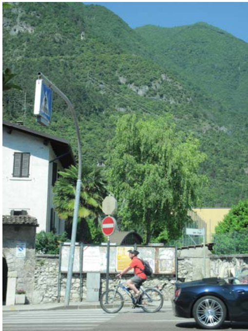
Viale Dei Tigli: palo fuori piombo per sostegno apparecchio di illuminazione dedicato ad attraversamento pedonale.
