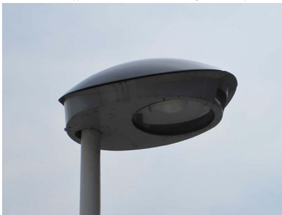
Via Filanda: armatura stradale dotata di vetro di chiusura piano classificabile come apparecchio di classe A ai sensi dell'Allegato C al Piano provinciale
